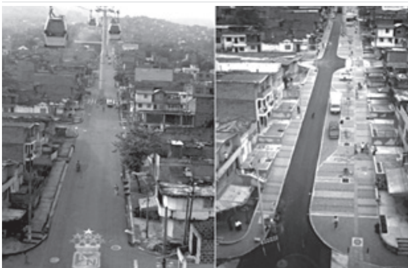
Figura 2. Recuperación de vías de ingreso a la Comuna Nororiental y Metrocable
